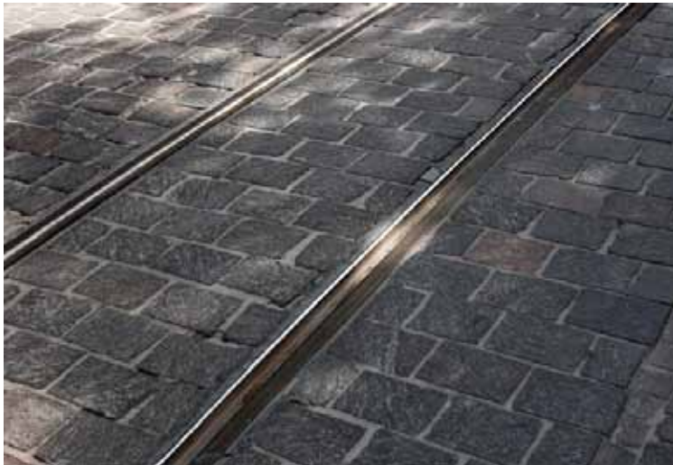
verharding rijvlak: ruwe grijze plaveien
